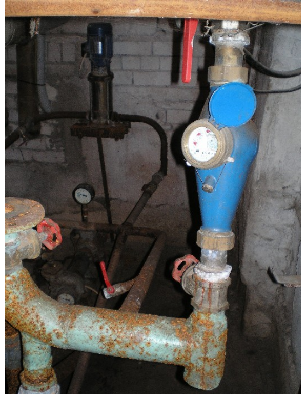
See arvesti Ida-Virumaal on paigaldatud VALESTI
